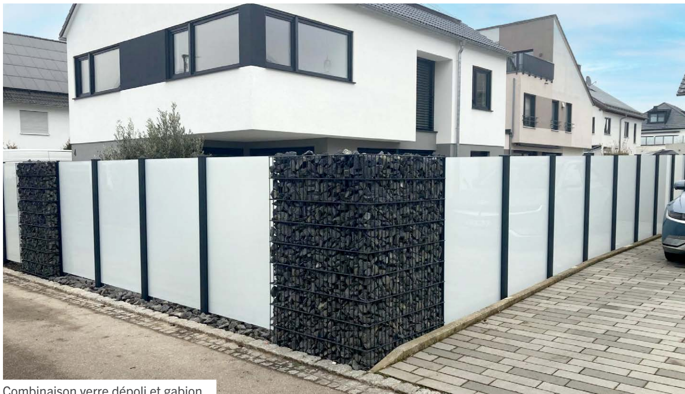
Combinaison verre dépoli et gabion
